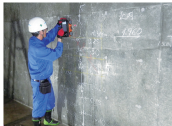
非破壊試験による鉄筋探査
